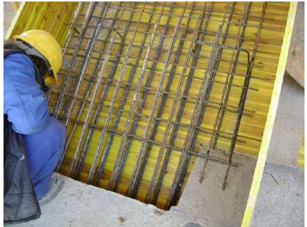
Montaje ferrallado escalera
