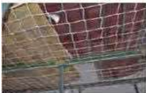
Red reutilizable anclada en placas metálicas
