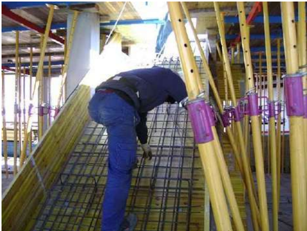
Montaje ferrallado escalera
