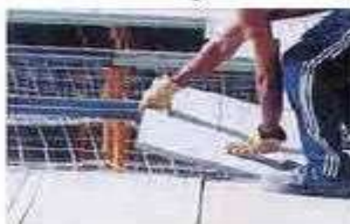
Entablado con la red instalada.
