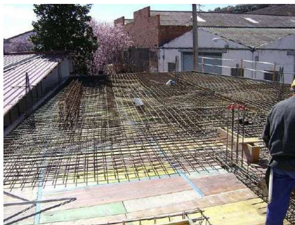
Montaje ferrallado en forjado
